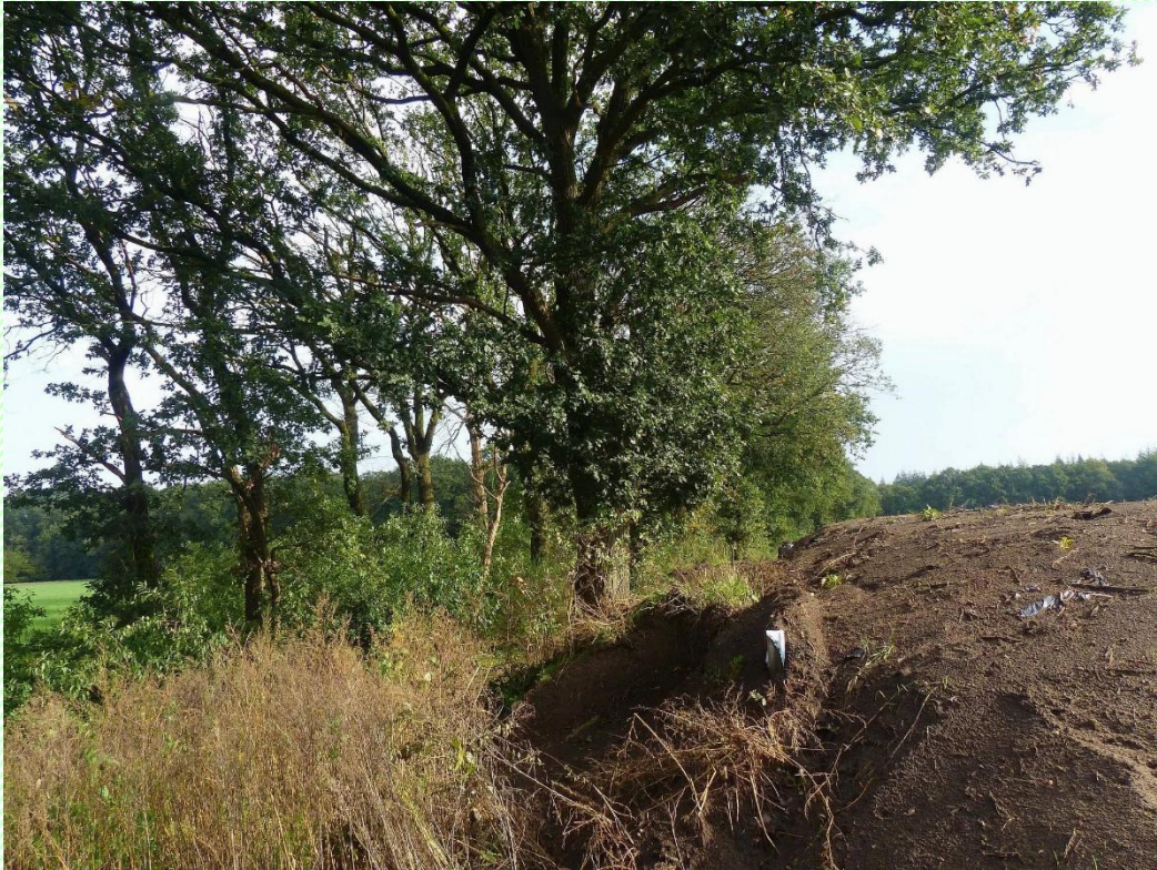
Figuur 1 Voorbeeld uit het stuk van Follow the Money: doorgraven wortels voor aanleg kuilplaat. De hele rij bomen is nu dood
